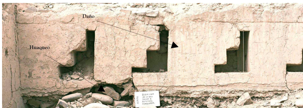
Foto 1 Muro con frisos (vista del daño sufrido)
