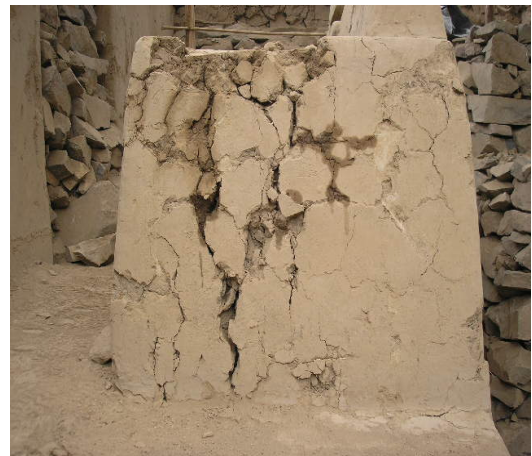
LADO EXTERNO DE ESCULTURA (NOR OESTE) DO DE CONSERVACIÓN DESPUES DE LA DE MATERIAL QUE CUBRÍA PARTE DEL
