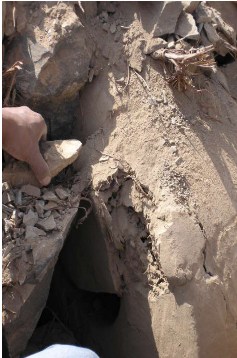
DETERIORO EN LA ESTRUCTURA DE BARRO A LA CAUSA DE PRESIÓN EJERCIDA POR PIEDRAS DOCUMENTACIÓN ANGULARES. VER EL SUSTRATO DESPRENDIDO PROTENCIÓN.
