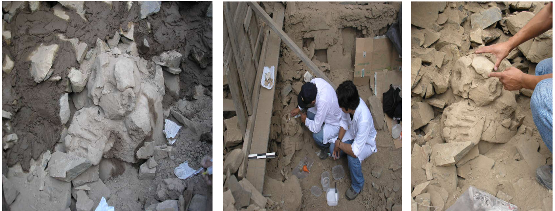
EL MORTERO DE BARRO APLICADO SOBRE EL RELLENO ESTABILIZARA AL MATERIAL SUELTO AL MOMENTO DE SECAR. SE HA COLOCADO UNA PLANCHA DE MADERA PARA PROTEGER A LA ESCULTURA DE CUALQUIER DESPRENDIMIENTO QUE PUEDA AFECTAR AL PERSONAJE DE BARRO.
