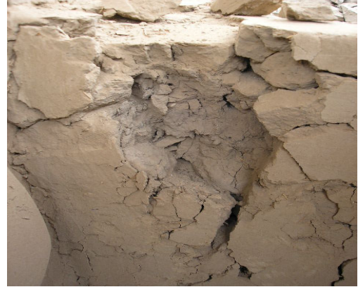
DETALLE DE FRAGMENTACIÓN DEL SOPORTE Y Y SUSTRATOS.
