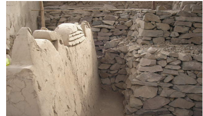
VISTA DEL MURO CON GRIETAS PROFUNDAS. DETALLE DE ESCULTURA Y MURO PROVISIONAL DE
