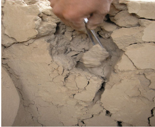
DETALLE DE ESCULTURA ATOMIZADA COMPROMETIENDO LA ESTRUCTURA DE BARRO.
